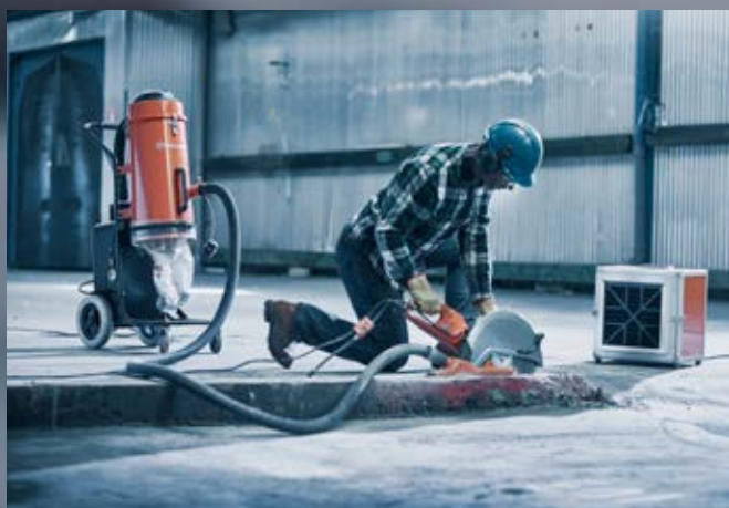
Pri suhem rezanju/vrtanju z integriranim zbiranjem prahu zadržite prah neposredno pri izvoru. Zbiralnik prahu H-klasifikacije z ustreznim pretokom zraka in kapaciteto, opremljen s HEPA H13 filtri, poskrbi za prah. Okoliški zrak se filtrira z enim ali več prenosnimi čistilniki zraka, ki so opremljeni s HEPA H13 filtri, vsaj 6–10 krat/uro.
