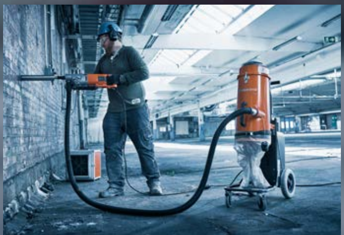
Pri suhem rezanju/vrtanju z integriranim zbiranjem prahu zadržite prah neposredno pri izvoru. Zbiralnik prahu H-klasifikacije z ustreznim pretokom zraka in kapaciteto, opremljen s HEPA H13 filtri, poskrbi za prah. Okoliški zrak se filtrira z enim ali več prenosnimi čistilniki zraka, ki so opremljeni s HEPA H13 filtri, vsaj 6–10 krat/uro.
