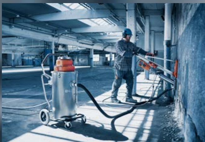
Mokro rezanje/vrtanje veže prah z vodo neposredno pri izvoru. Z zbiralnikom brozge, priključenim na sesalnik za brozgo, poskrbite za čistočo delovnega mesta.
